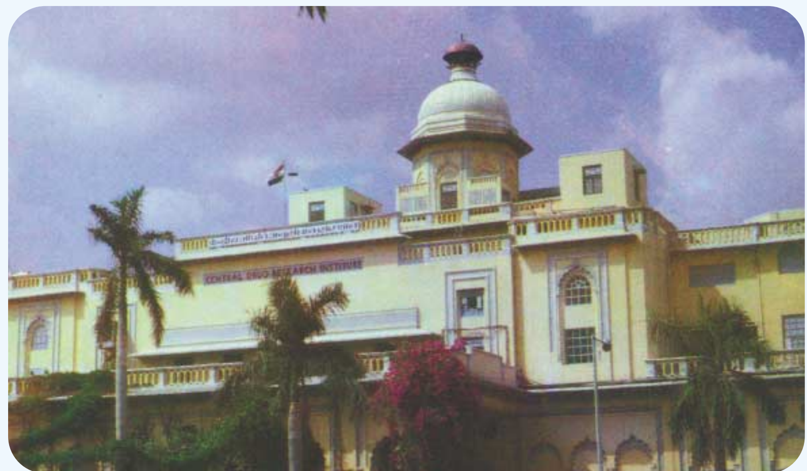
Ein ehemaliger Maharadscha-Palast ist neben vielen modernen Gebäuden Teil des CDRI-Komplexes.
